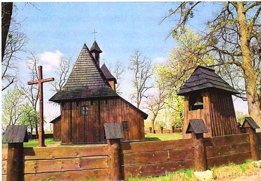
Fotografia 16 i 17. Kościół filialny pw. Świętej Trójcy w Pątnowie
