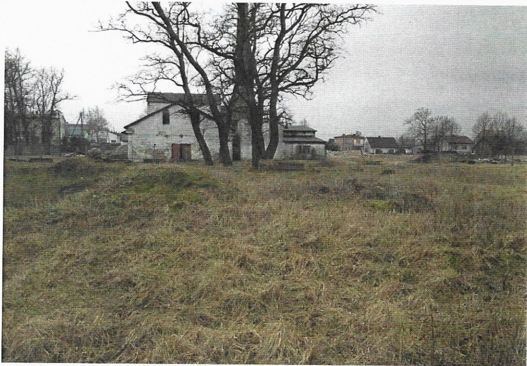
Fot. Istniejący stan dz. 308 z budynkiem po byłej gorzelnii
