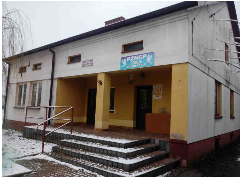
Fot. 1 Elewacja i północna
