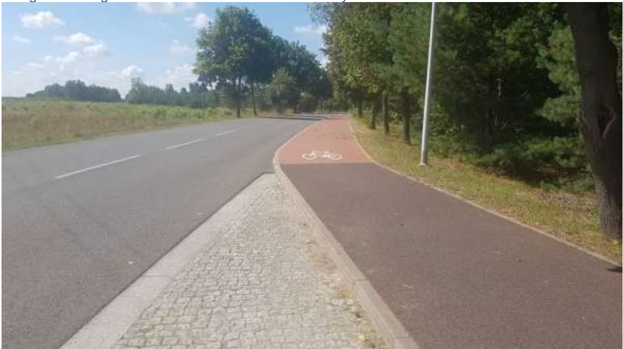
Fotografia 6 Droga rowerowa z Kleszczowa do Sulmierzyc
