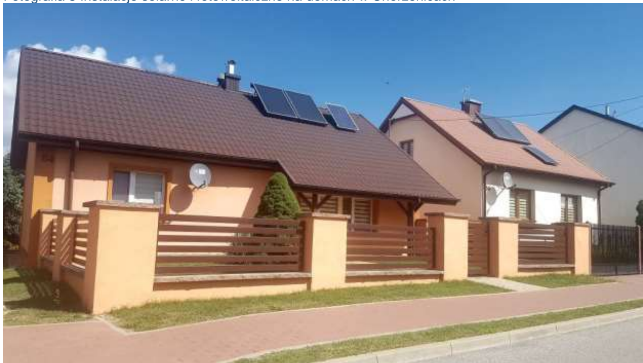
Fotografia 8 Instalacje solarne i fotowoltaiczne na domach w Chorzenicach
