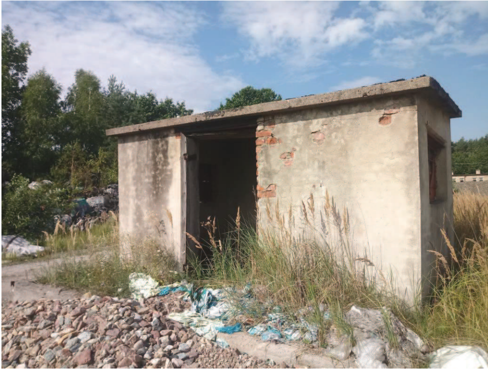
Fot. 1 Budynek murowany
