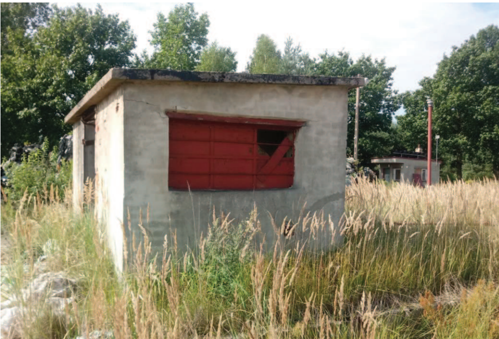
Fot. 2 Budynek murowany
