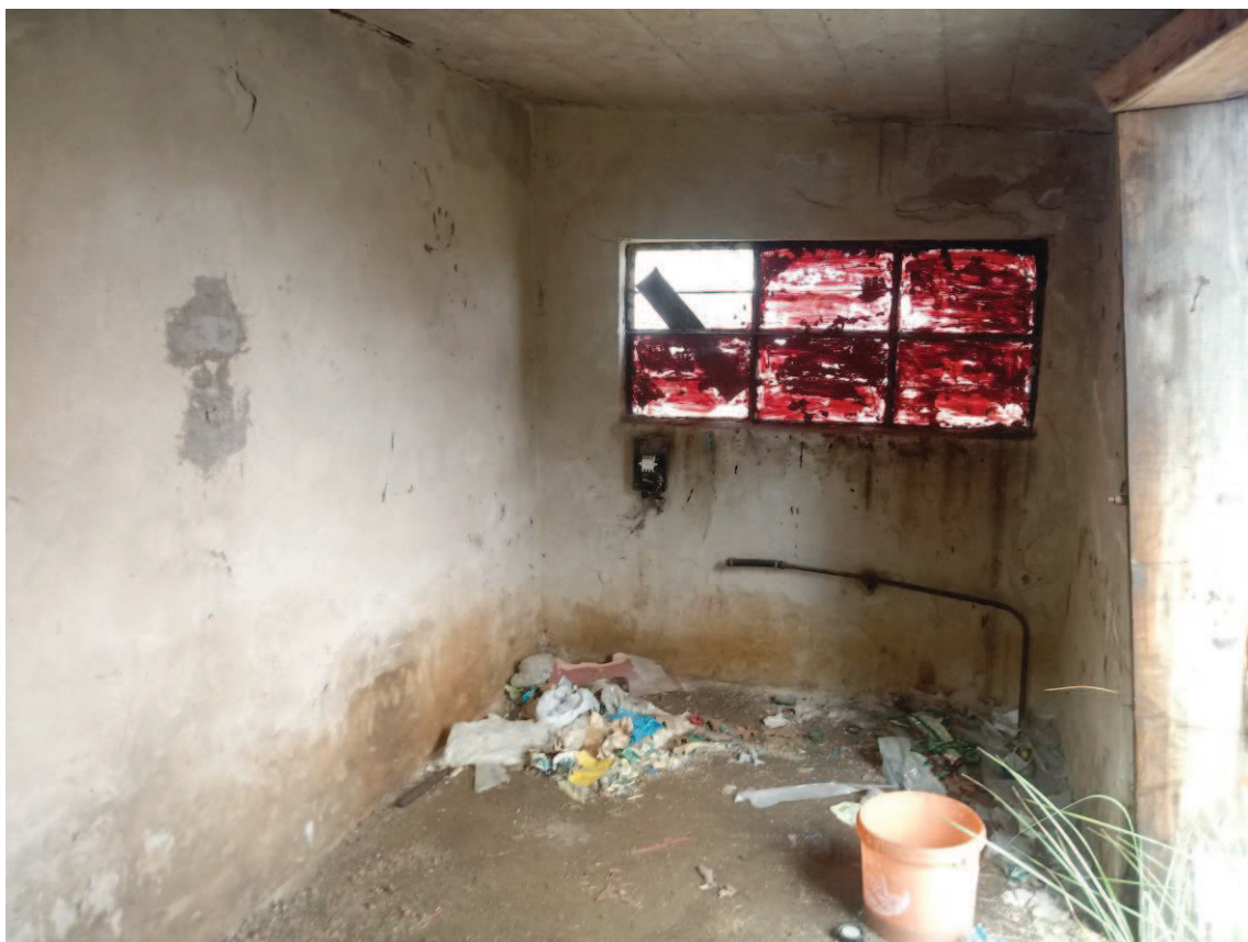
Fot. 3 Budynek murowany - wewnątrz
