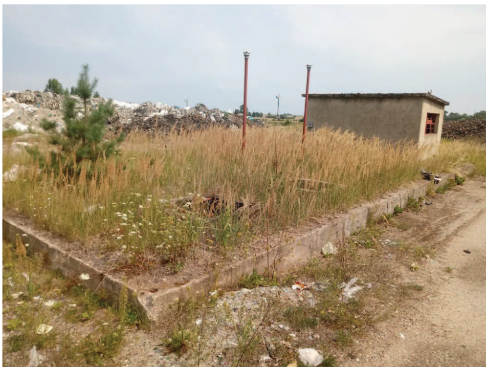
Fot. 7 Teren rozbiórki
