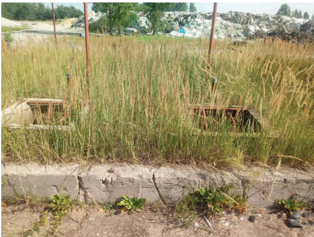
Fot. 5 betonowe murki oporowe
