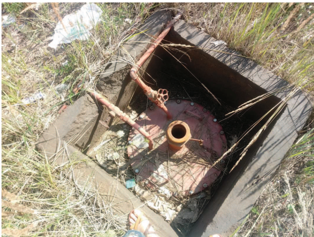
Fot. 4 Studzienka wjazdowa zbiornika podziemnego
