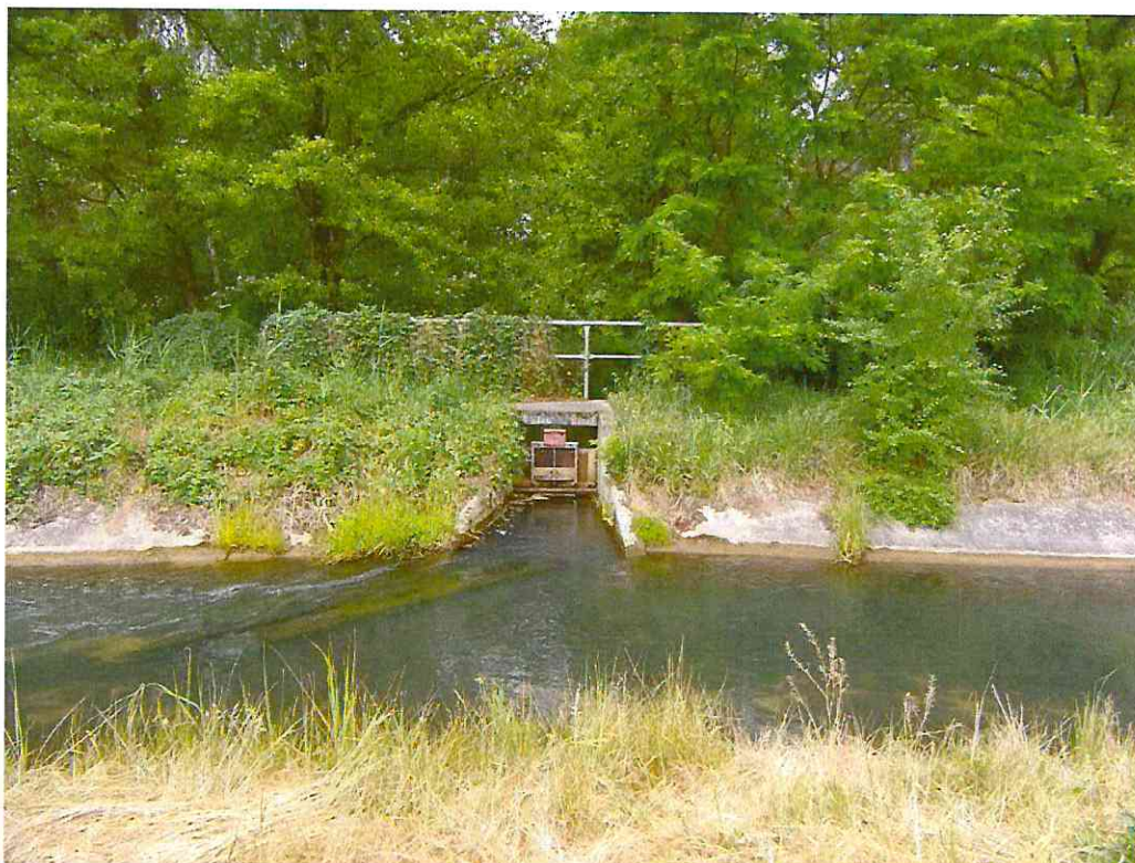
Zdj. 1. Zapora nawadniająca zbiorniki w miejscowości Dygudaj z nowego koryta rzeki Krasowa
