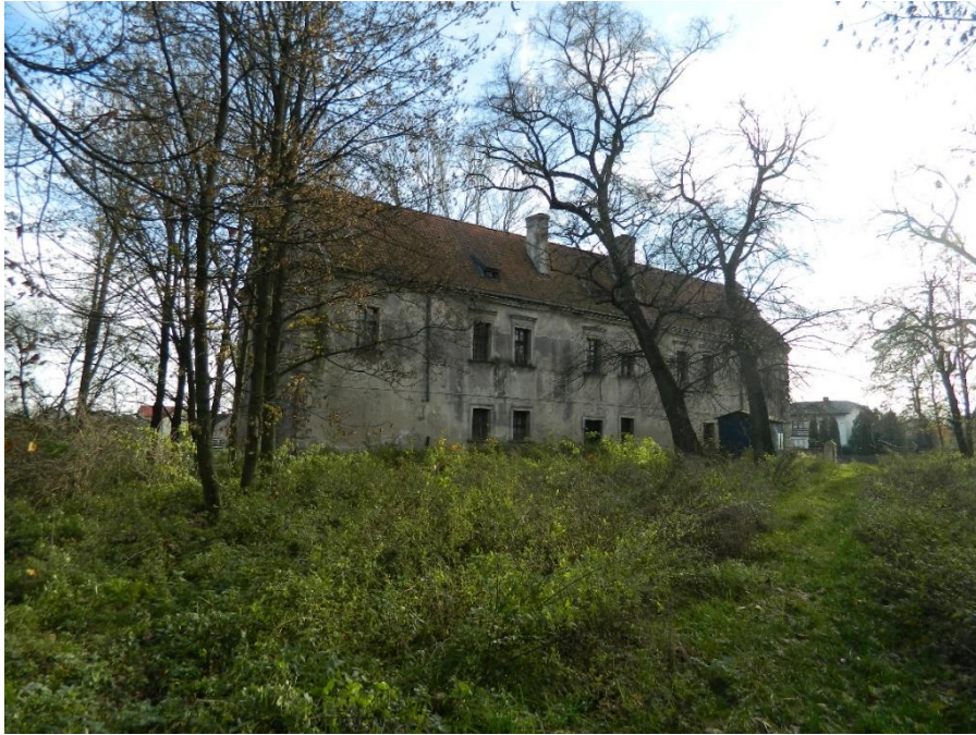
Chorzenice - dwór-lamus z XVII w. – elewacja wschodnia (fot. M. Urbański)
