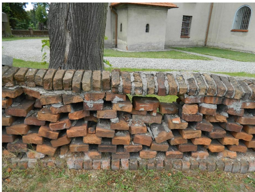
Sulmierzyce – fragment ogrodzenia kościoła pw. św. Erazma (fot. M. Urbański)
